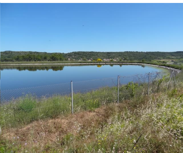
Bassin d'évaporation existant, bordé de zones rudérales
